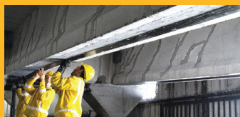
REPARACIONES Y REFUERZO
