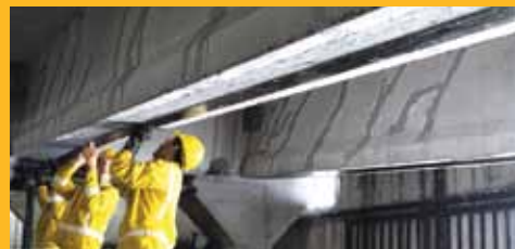
REPARACIONES Y REFUERZO
